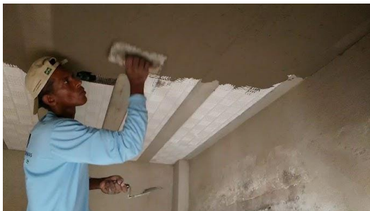
Figura 14: detalhe laje rebocada.
