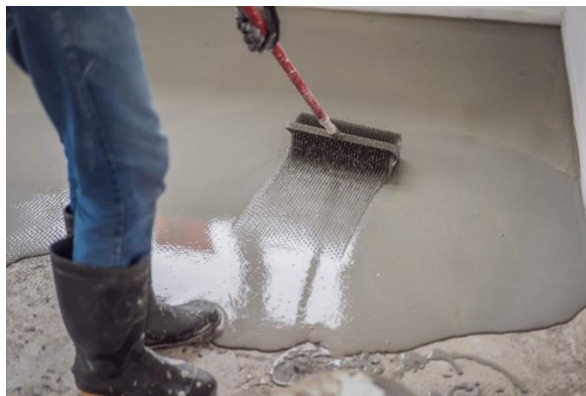
Figura 09: detalhe argamassa autonivelante.
