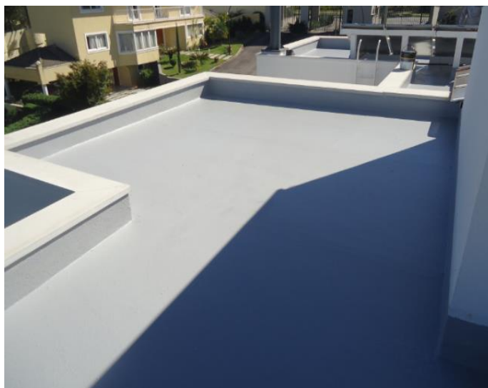
Figura 02 - detalhe de laje impermeabilizada.
